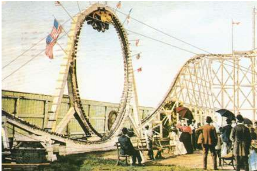
Fot. 2. Kolejka Flip Flap Railway w Coney Island w Nowym Jorku. Wartości przeciążeń na jej pętli sięgały 12 g . Źródło: [11]
